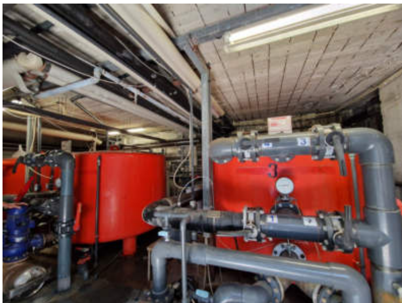
Fig. 5 – Stazioni di filtraggio acqua piscine
