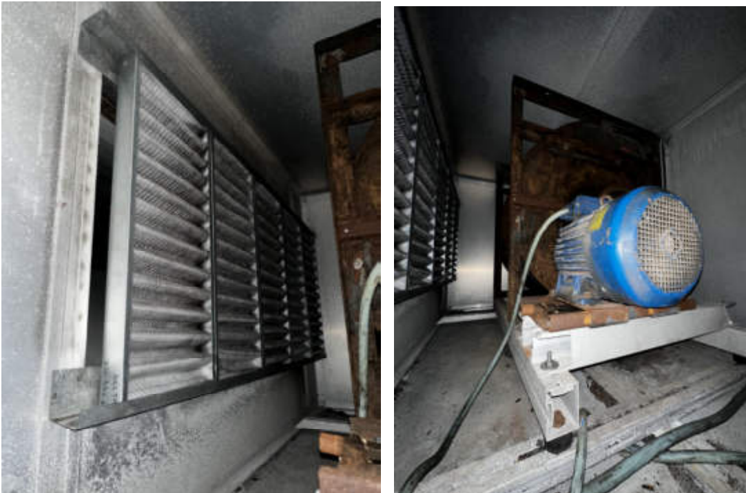
Fig. 10 – Filtro e ventilatore di mandata
