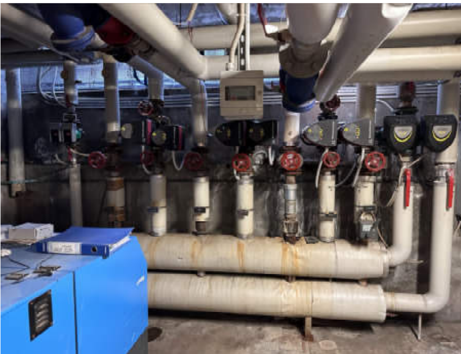
Fig. 3 – Collettore di alimentazione delle varie utenze
