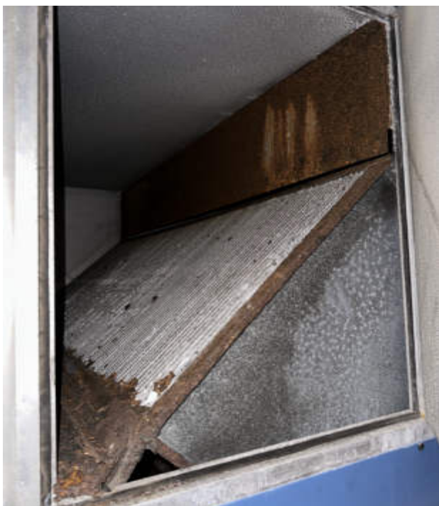
Fig. 8 – Scambiatore di calore della UTA
