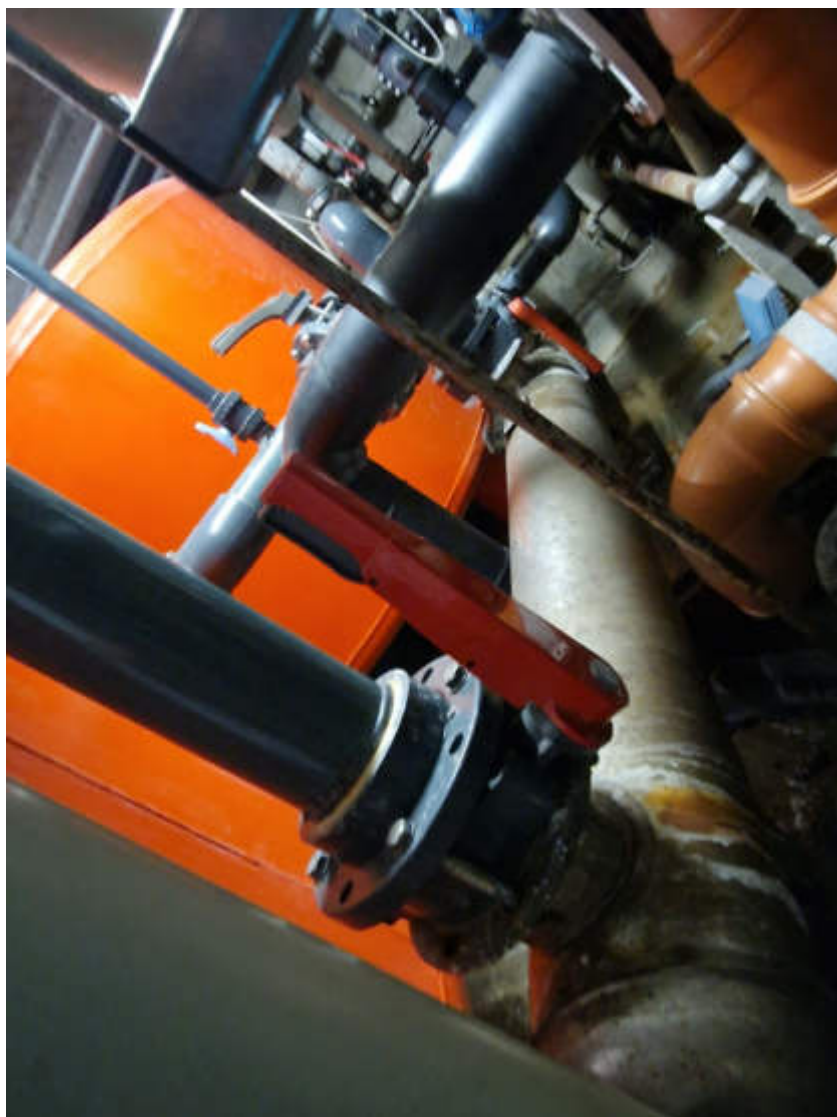
Fig. 6 – Scambiatore di calore per riscaldamento acque piscine
