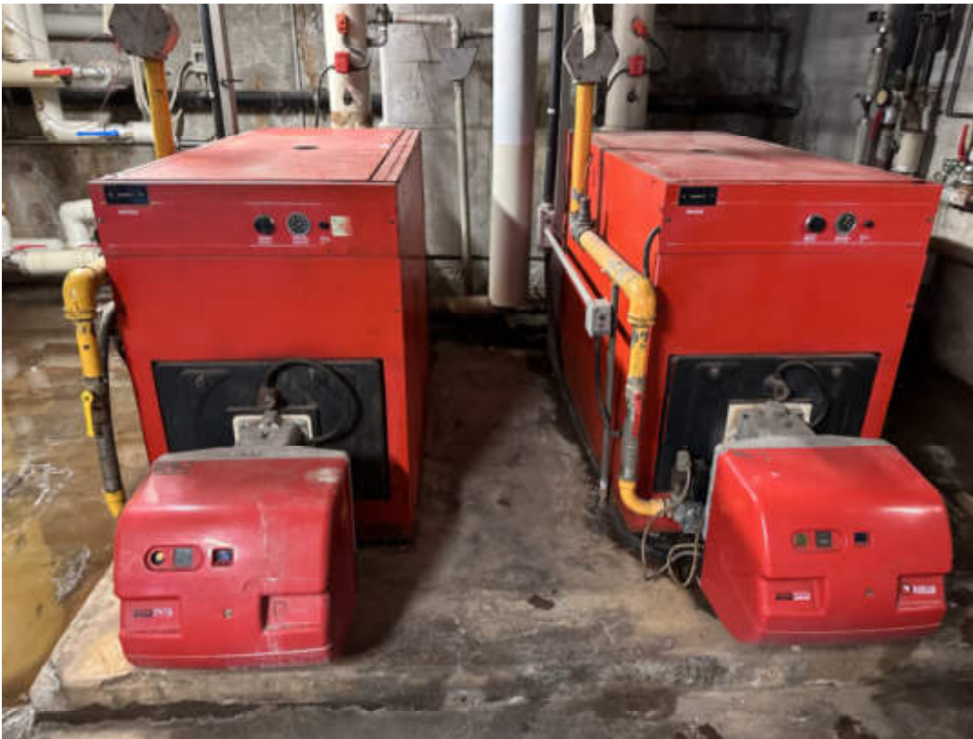
Fig. 2 - A sinistra caldaia principale ( P = 325\text{KW} ), a destra caldaia secondaria ( P=325\text{KW} )
