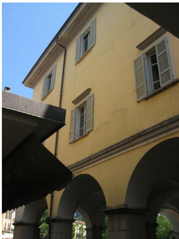
La parte vecchia dell'edificio.
