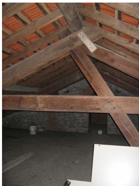
La copertura vista dal solaio interno.
